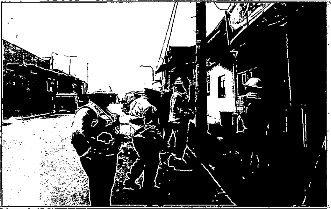
Imagen N°03: Supervisión de ejecución de trabajos
