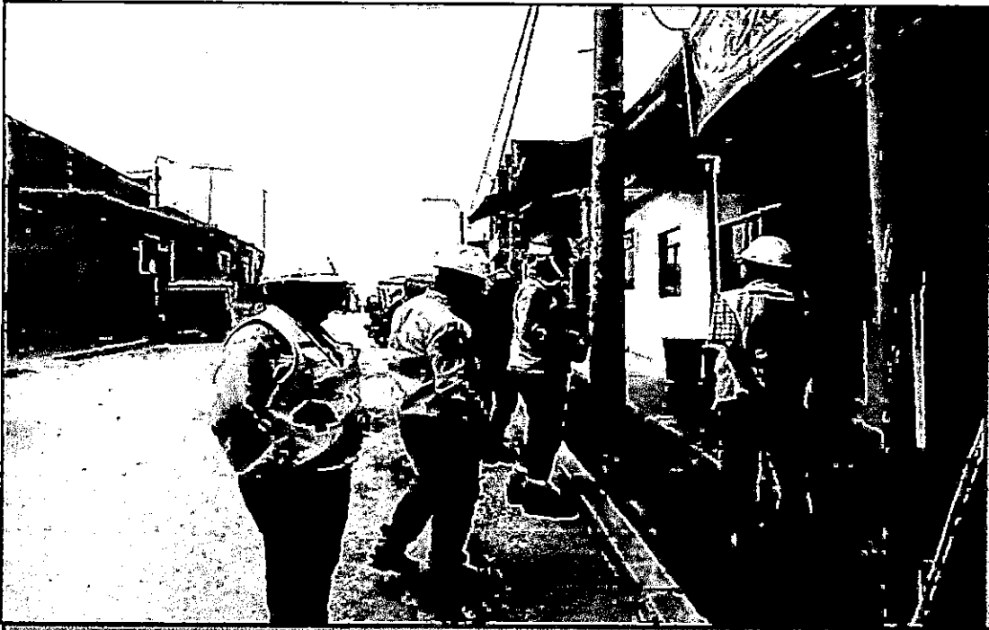
Imagen N°03: Supervisión de ejecución de trabajos
